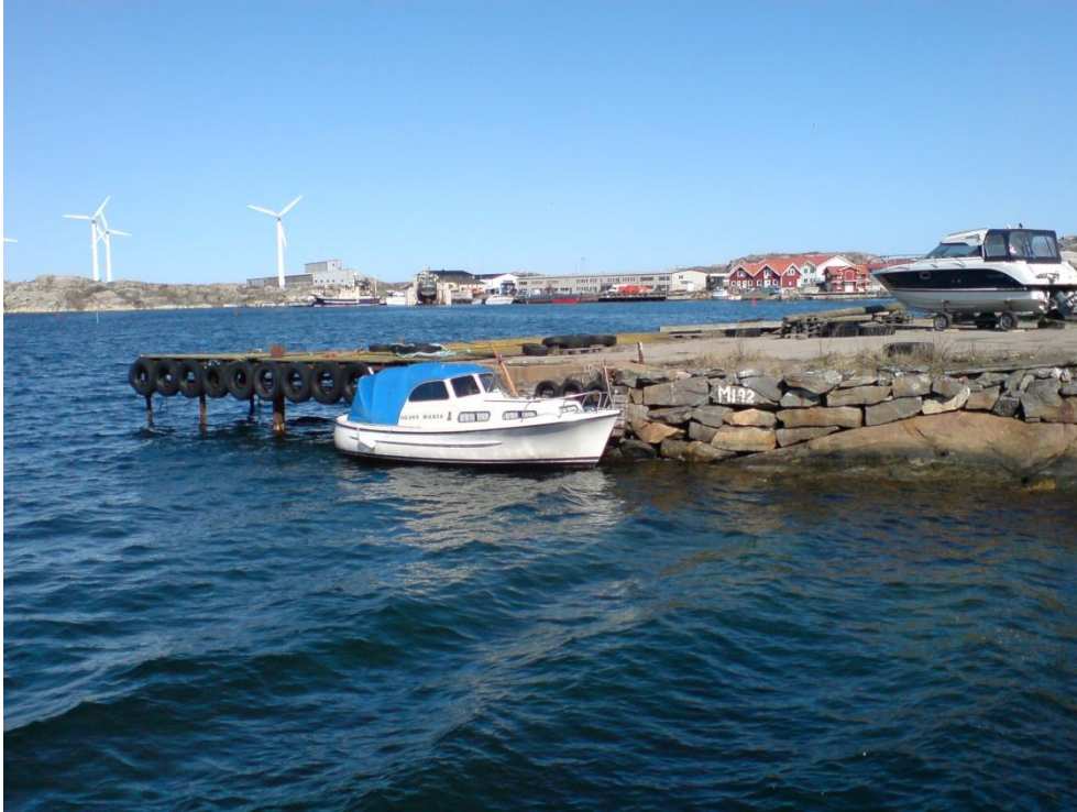
Bild 9. Befintlig kajkonstruktion i norra delen av området. Vy åt norr.
