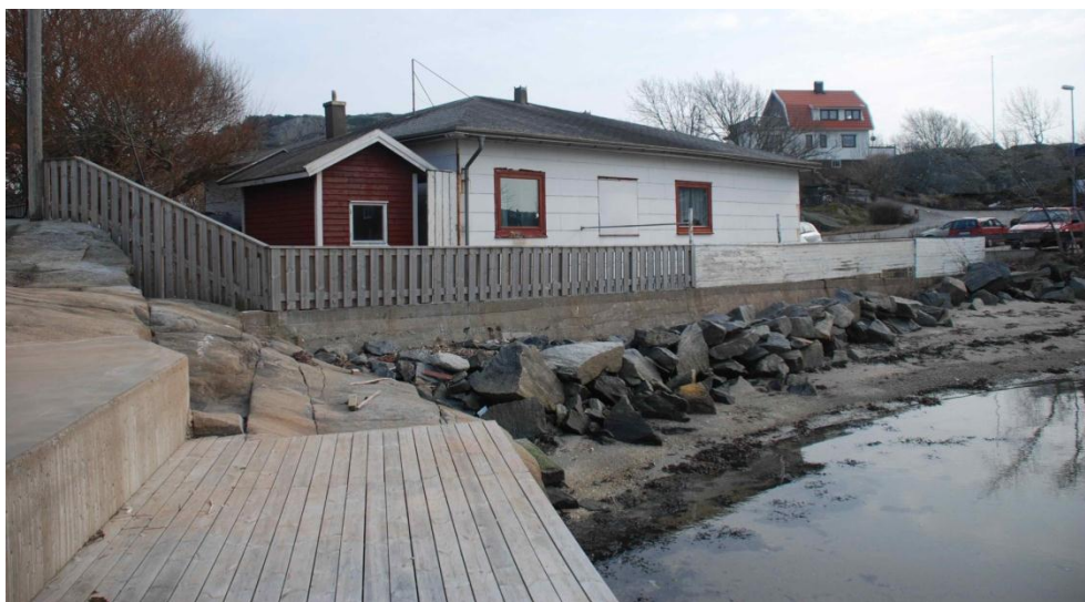
Bild 7. "Berg i dagen" i anslutning till fastighet Rönnäng 1:149. Vy åt sydost.
