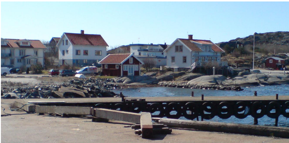
Bild 6. Fastighet Rönnäng 1:55 är grundlagd på berg. Vy åt söder.
