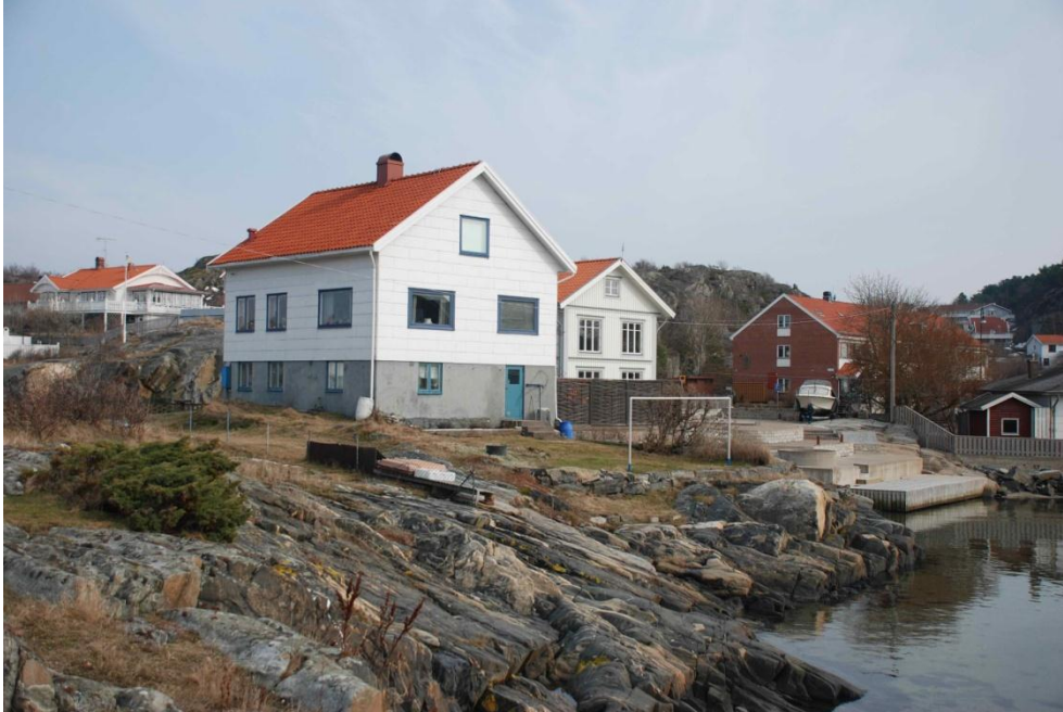
Bild 5. Fastigheterna Rönnäng 1:80 och 1:54 är grundlagda på berg. Vy åt öster
