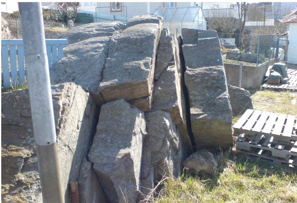
Bild 11. Riskområde (B2) för blockutfall. Vy åt sydost.
