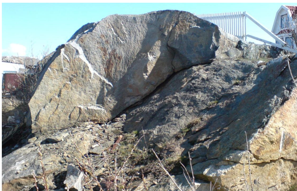
Bild 10. Riskområde (B1) för blockutfall. Vy åt öster.
